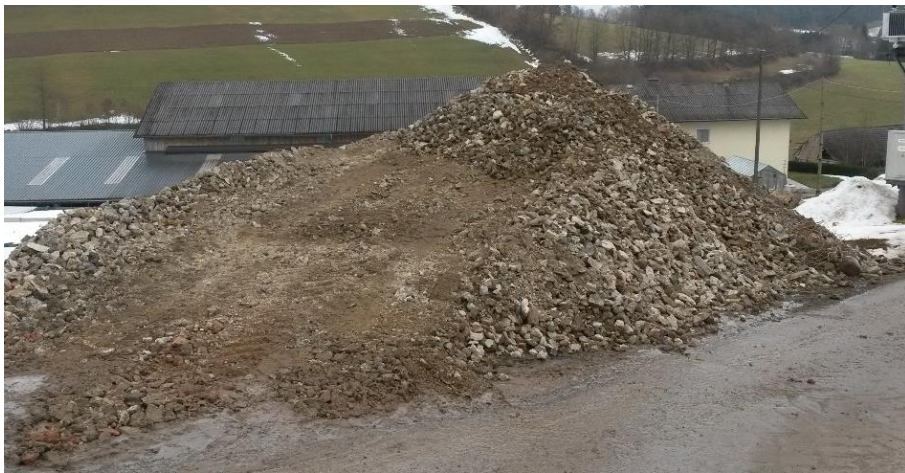
ca. 150 m 3 mineralischer Bauschutt nach dem Abbruch
